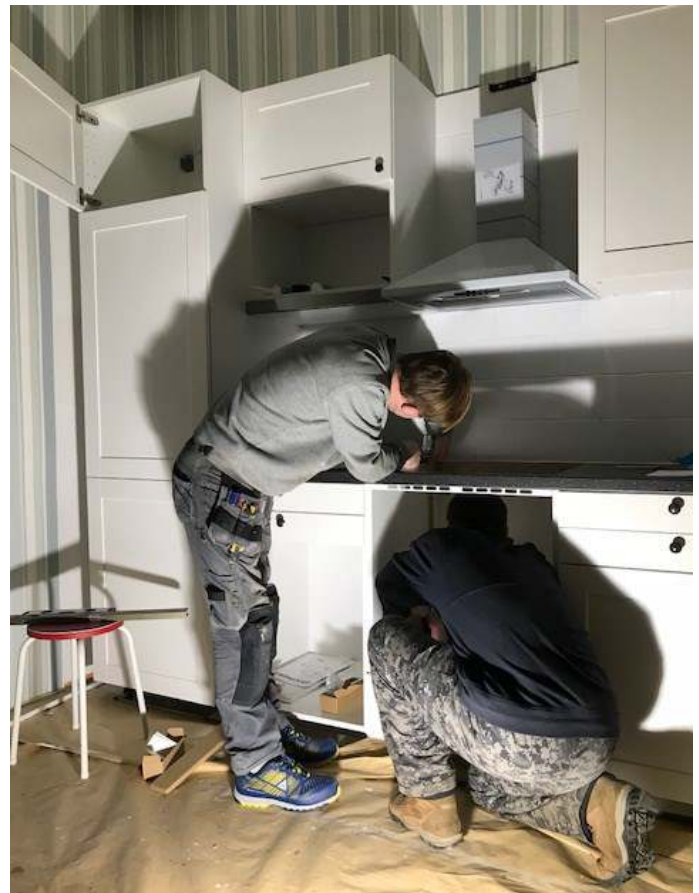
Ari ja Harri asennushommissa
