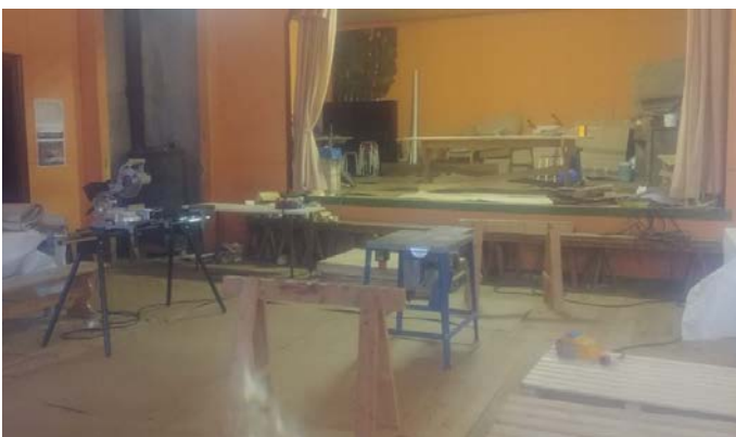
(4) Kun katto oli suojassa, siirryimme sisätiloihin. Ensin suojattiin salin ja näyttämön lattia ja perustettiin työpisteet koneineen.
