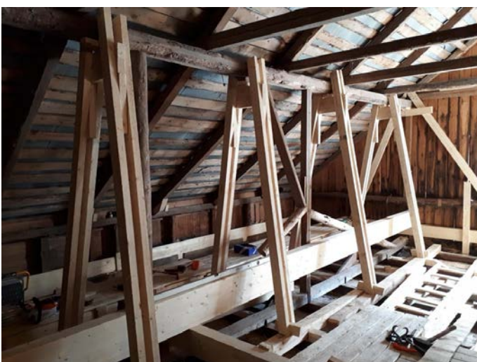
(13) Täälläkin piti tehdä työaikainen tuenta. Huom. näissä kuvissa näkyvät palkit siirrettiin pihalta portaikon kautta käsivoimin, kantamalla, ullaalle. Kiitos rohkeille mukana olleille!
