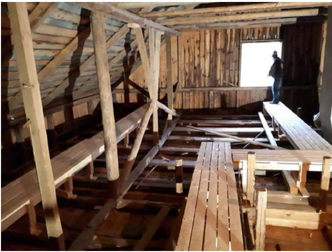
(5) Siltojen jo osittain valmistuttua päästiin melkein tukirakenteiden kimppuun...
