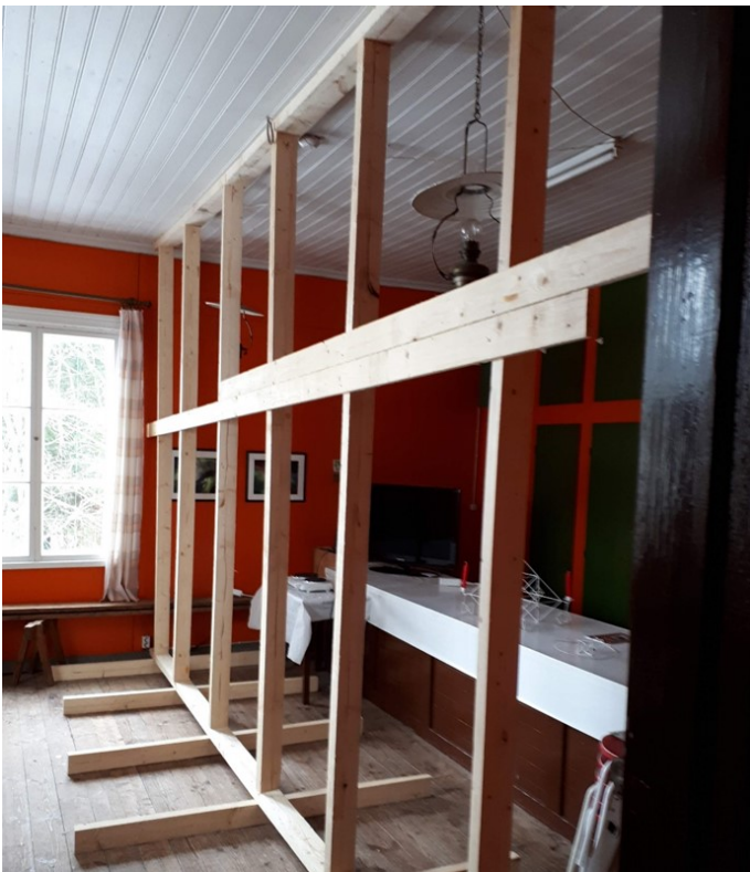
(12) Ruokasalin katto piti tukea, ennen kuin uskallettiin puuttua katon kannakkeisiin.
