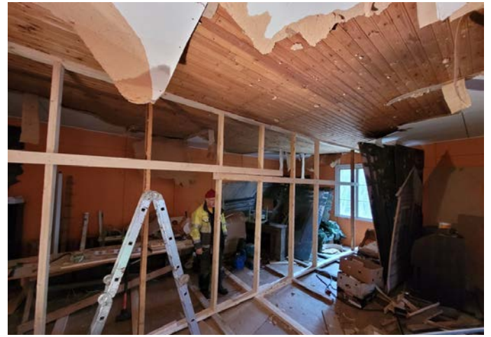
(14) Siirtyessämme jiirin suuntaan on näyttämön katto tuettava. Aika haperossa kunnossa. Halteksin alta paljastui alkuperäinen helmipanelointi.
