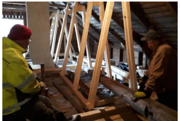
(9) Ensin tuettiin kammarin ja keittiön päällä kulkeva kannakointi. Tässä pohditaan, että kuinka käsivoimin siirretään suht' massiivinen tukki osaksi rakennetta. Pohtimassa Harri Koistinen (vas.) ja Seppo Tallqvist (oik.).
