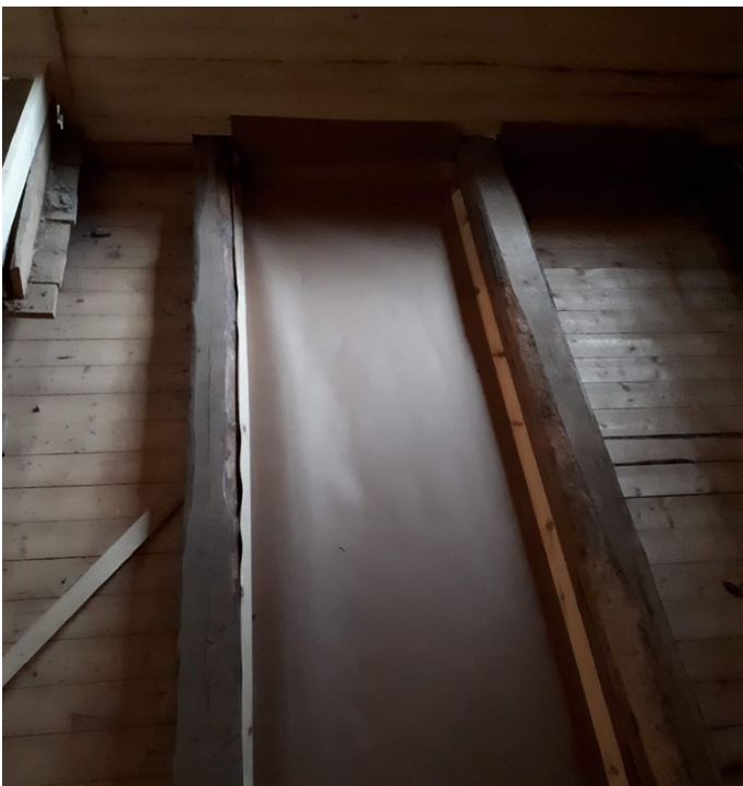
(7) Tällaiselta paperointi vaihe näyttää. Tätä työtä on vielä rakennuksen muissa osissa runsaasti tarjolla.
