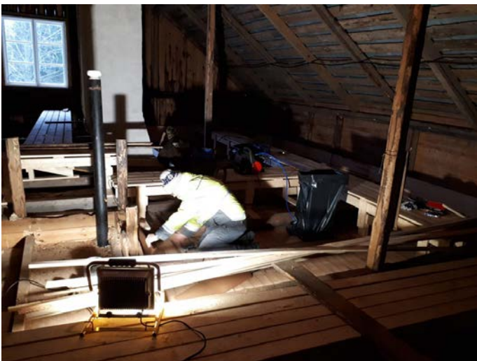
(6) ... mutta sitä ennen piti eristää ja villoittaa kammarin ja keittiön katto, jotta niiden lämmittämisessä olisi edes hieman järkeä. Välipohja piti vielä kerran siivota ja paperoida.
